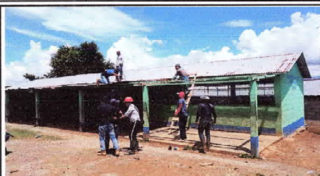
Foto1: Desmantelamiento del techo para la ejecución del proyecto
