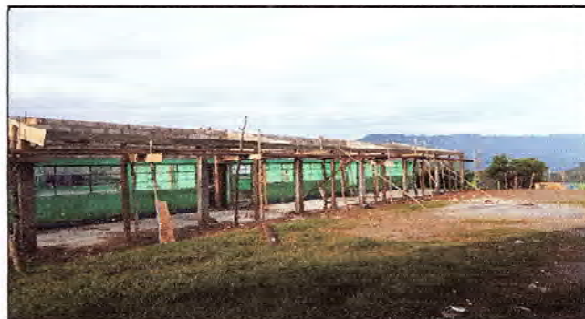
Foto 4: colocación de 3 hiladas de block para el levantamiento del techo.
