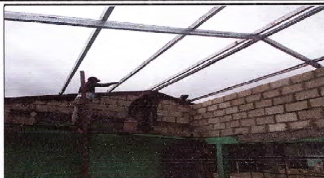
Foto 2: Retiro de vigas de madera por costaneras metálicas.
