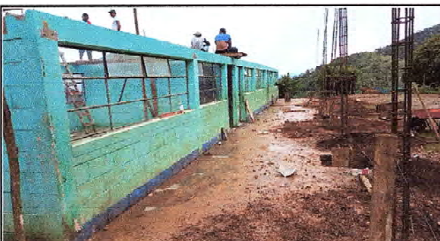
Foto 3: Colocación de columnas.
